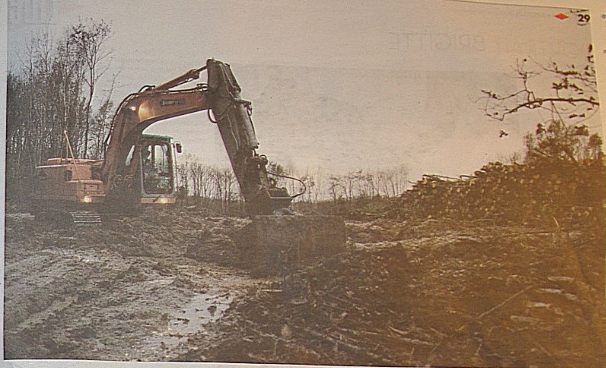
Après le déboisement, des bulldozers ont déjà attaqué le terrassement de la voie d'accès au futur village de vacances.
